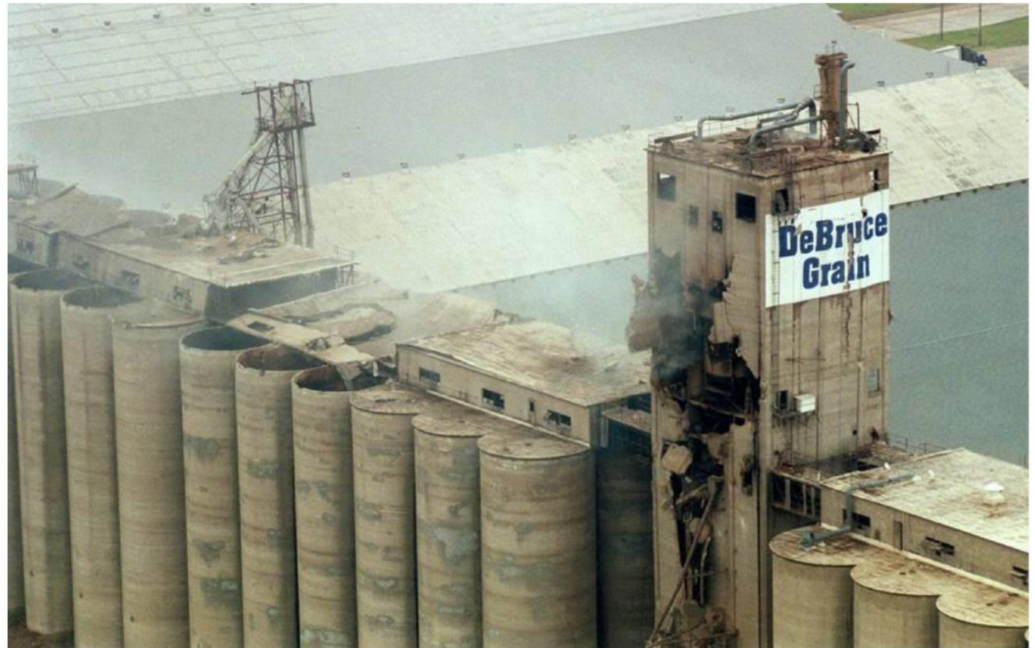
Figura 01: Efeitos da explosão na casa de máquinas e a galeria sobre os silos da extremidade norte.
